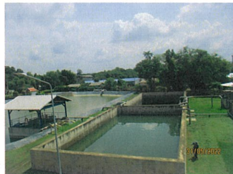
ภาพที่ 2-12 บ่อพักน้ำทิ้ง (Retention pond)
