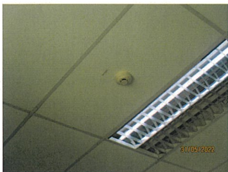
ภาพที่ 2-26 เครื่องตรวจจับความร้อน
