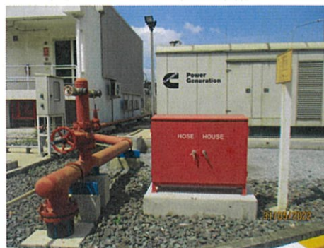
ภาพที่ 2-28 ระบบฉีดน้ำ และหัวฉีดน้ำดับเพลิง
