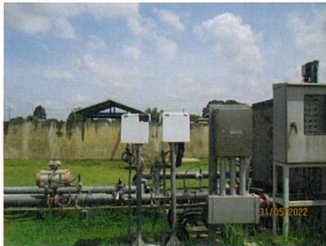
ภาพที่ 2-13 การติดตั้งระบบการเดินค่าการนำไฟฟ้า
