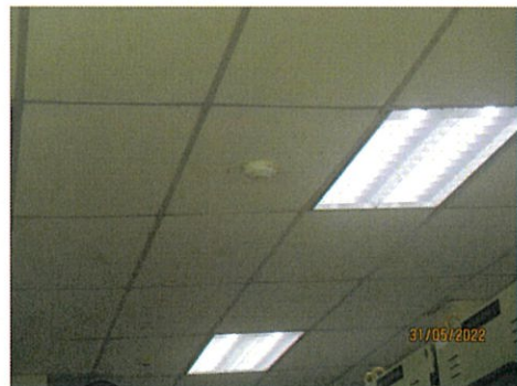
ภาพที่ 2-25 เครื่องตรวจจับควัน
