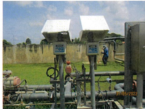
ภาพที่ 2-13 การติดตั้งระบบการเดินค่าการนำไฟฟ้า
