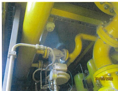
ภาพที่ 2-27 อุปกรณ์ตรวจสอบการรั่วไหลของก๊าซ
